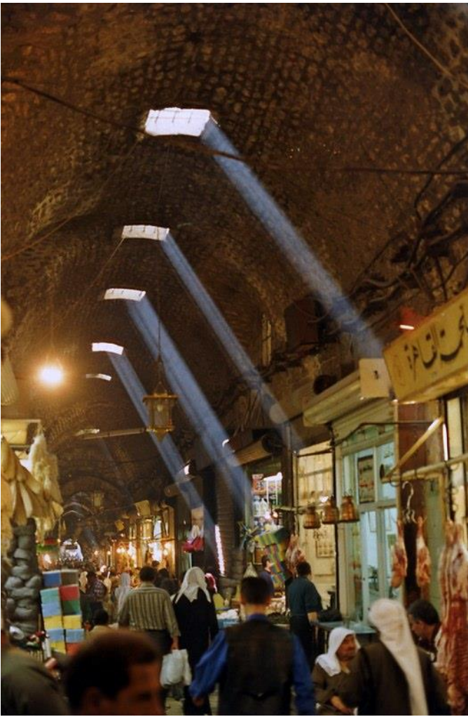
لوحة ( ٢ ) سوق مدينة حلب، أحد الأسواق المتفرعة من الطريق الرئيسى للسوق يوضح طريقة الإضاءة بالقبو الطولى.
